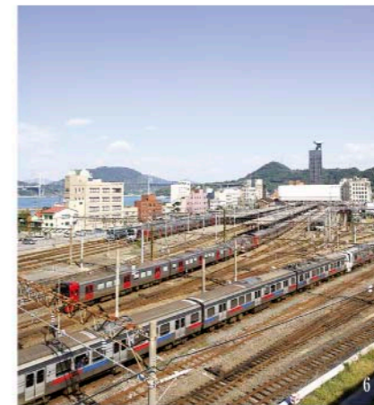
清滝側から見た門司港駅。白いもので覆われているのが工事中の門司港駅です。
