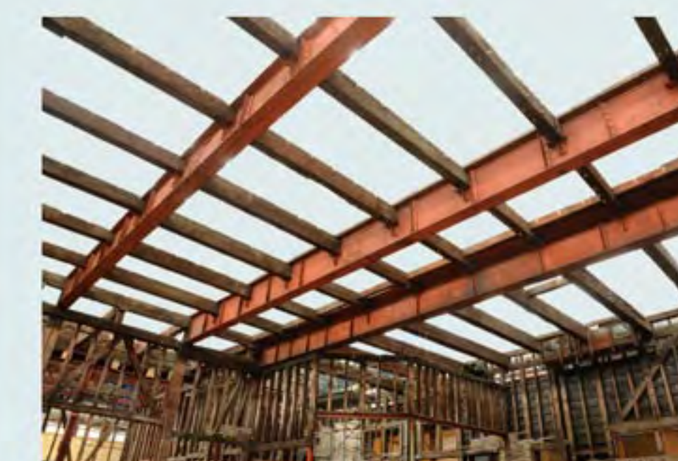
コンコースの天井裏にある鉄骨梁
