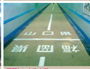
関門トンネル人道
